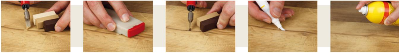
**Anwendungsbeispiel:** Mehrere Farbtöne auswählen, schmelzen und in Maserungsrichtung einbringen. Überschüssiges Wachs mit dem Füllstoff-Hobel abtragen. Die Holz-Struktur kann mit entsprechenden Farben angepasst werden. Am Ende mit dem Pinsel-Fix Klarlack oder dem Sprüh-König® Ansatzlos PLUS die reparierte Stelle versiegeln, um sie so vor Staub und Schmutz zu schützen.
